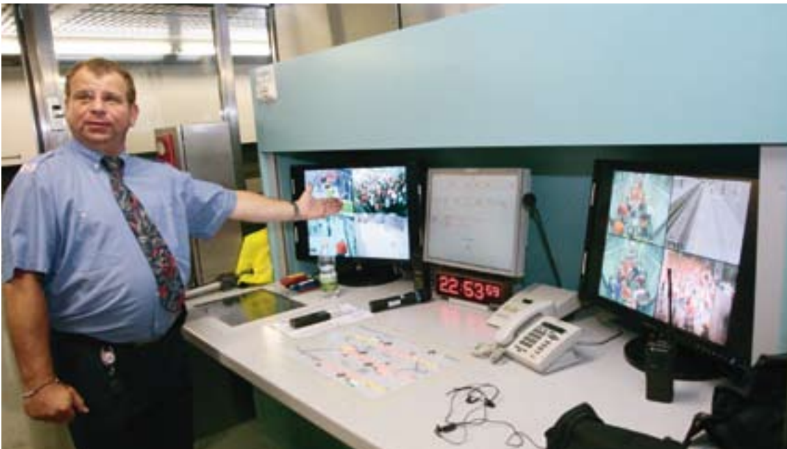
Überwachung des U-Bahnbetriebes in der zentralen Leitstelle der Wiener Linien
