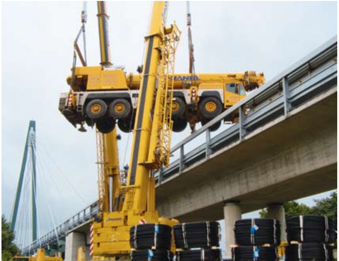
Schwerlastkran wird auf Schrägseilbrücke gehievt
