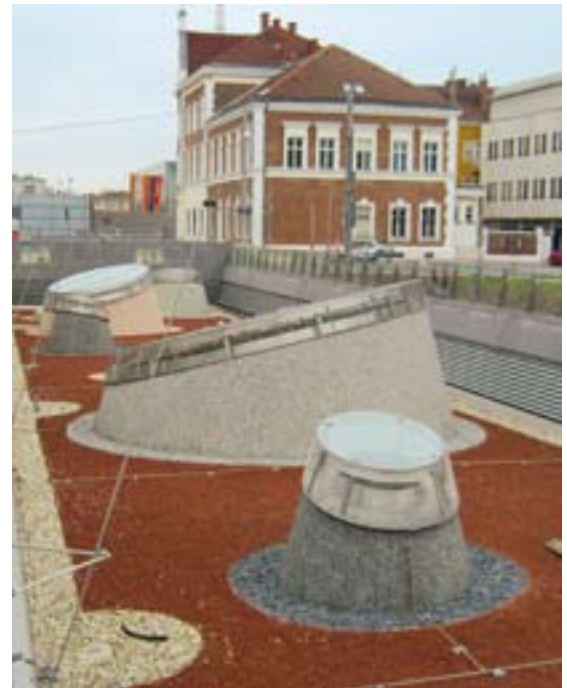
Blick auf die Solatubes
